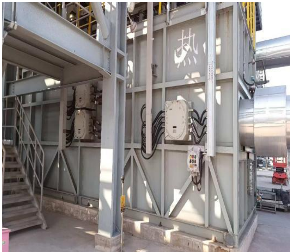
进料电加热器（1400kW）
