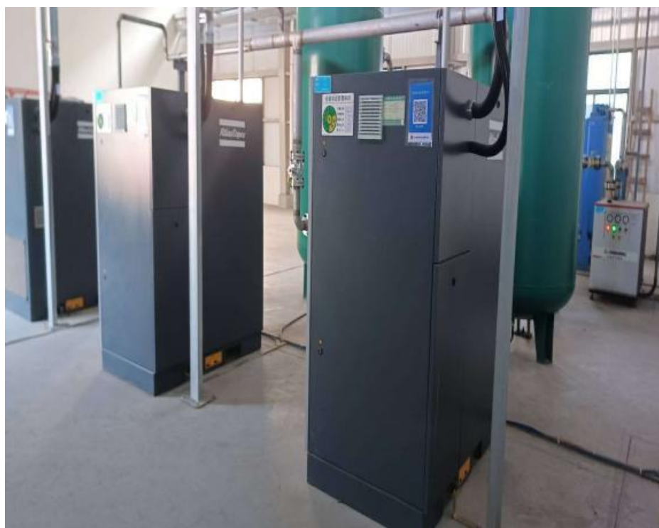
螺杆式空气压缩机
